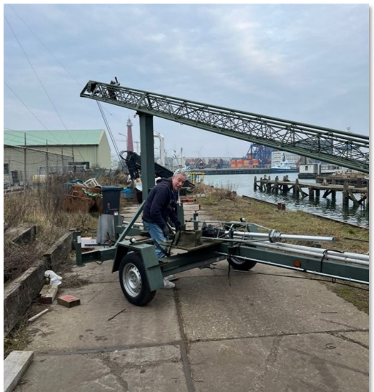
De tijdelijke mast ging na afloop weer weg van de helling
