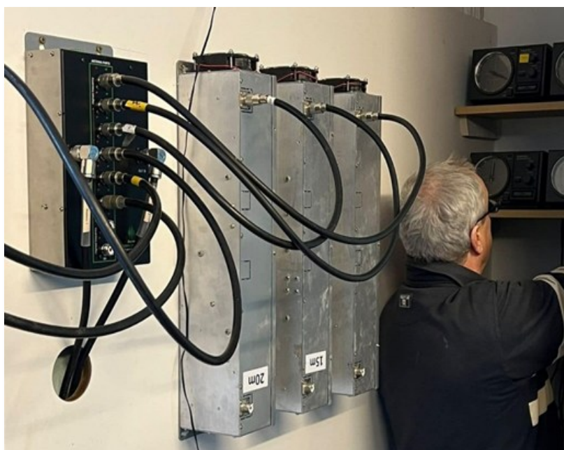
Installeren van de Antenna Genius, bandfilters en rotorbesturing
